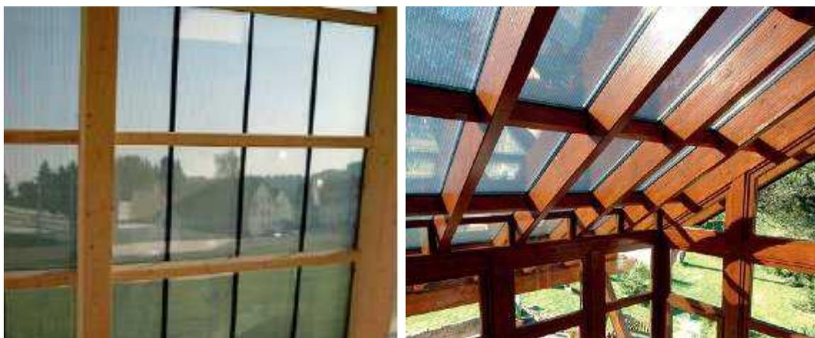
Figure 96 : Exemple d'intégration en façade et en verrière de panneaux semi-transparent Schott-Solar
