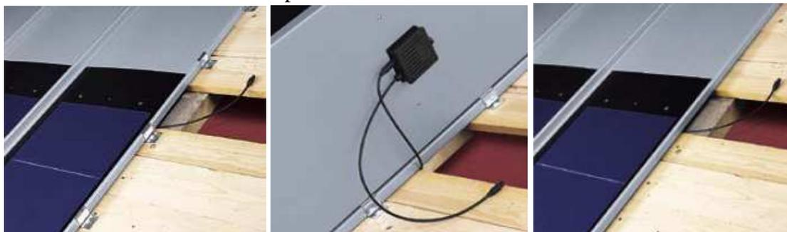
Figure 77: Mise en oeuvre des panneaux Rheinzink (d'après documentation constructeur)
