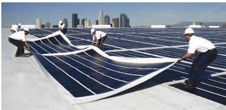
**Figure 82: Mise en place des membranes Solar Integrated**
