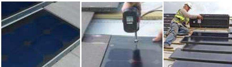
Figure 112: Détails du montage des tuiles SolarCentury
